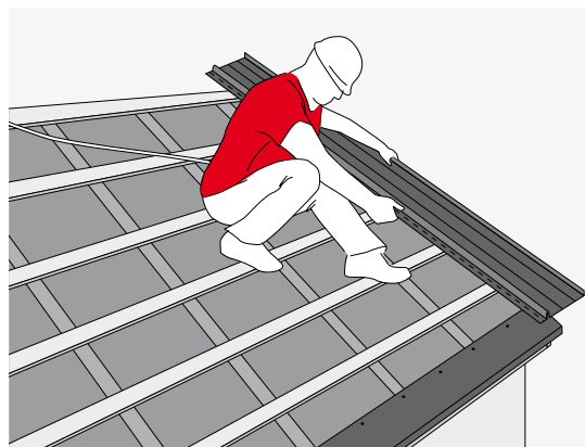
RYS. 16. UKŁADANIE PANELI DACHOWYCH
