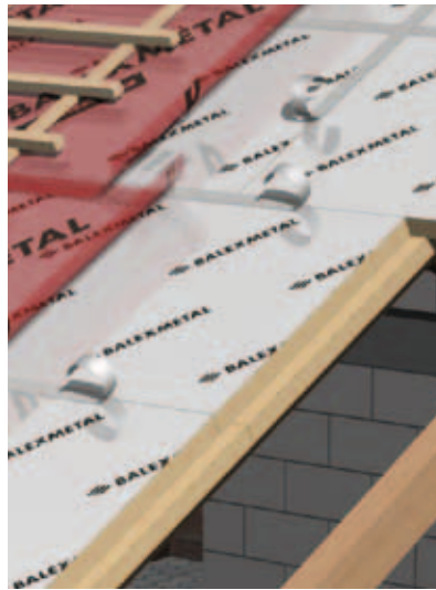
RYS. 14. USZCZELNIENIE POŁĄCZEŃ MIĘDZY PŁYTAMI ORAZ UŁOŻENIE MEMBRANY DACHOWEJ
